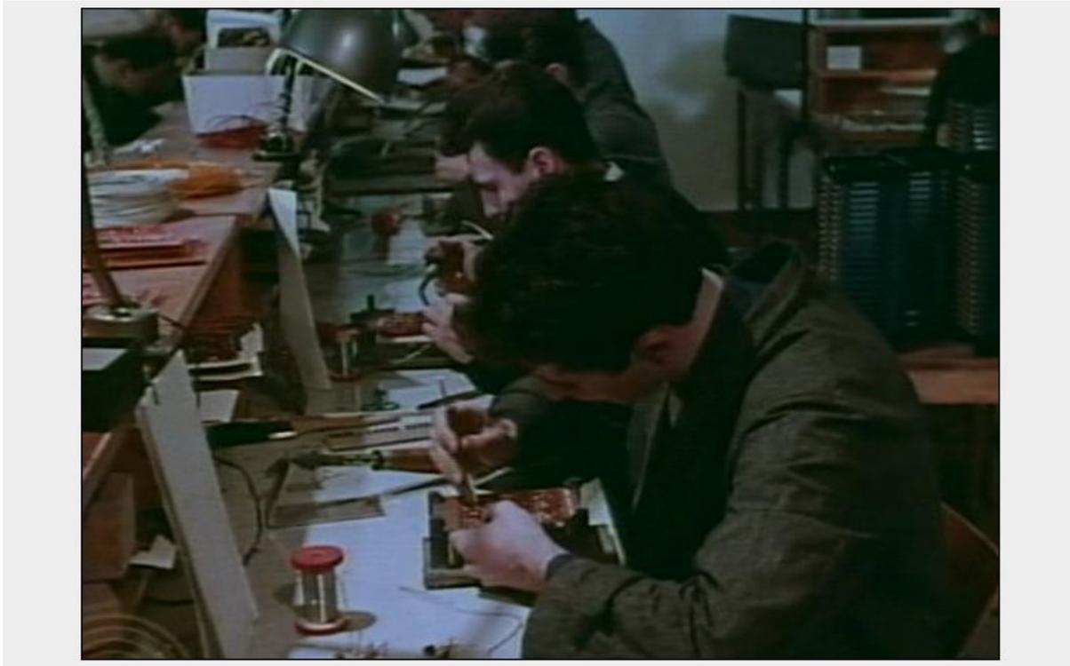
Reparto realizzazione singole schede a transistor
